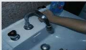
On ferme l'eau
